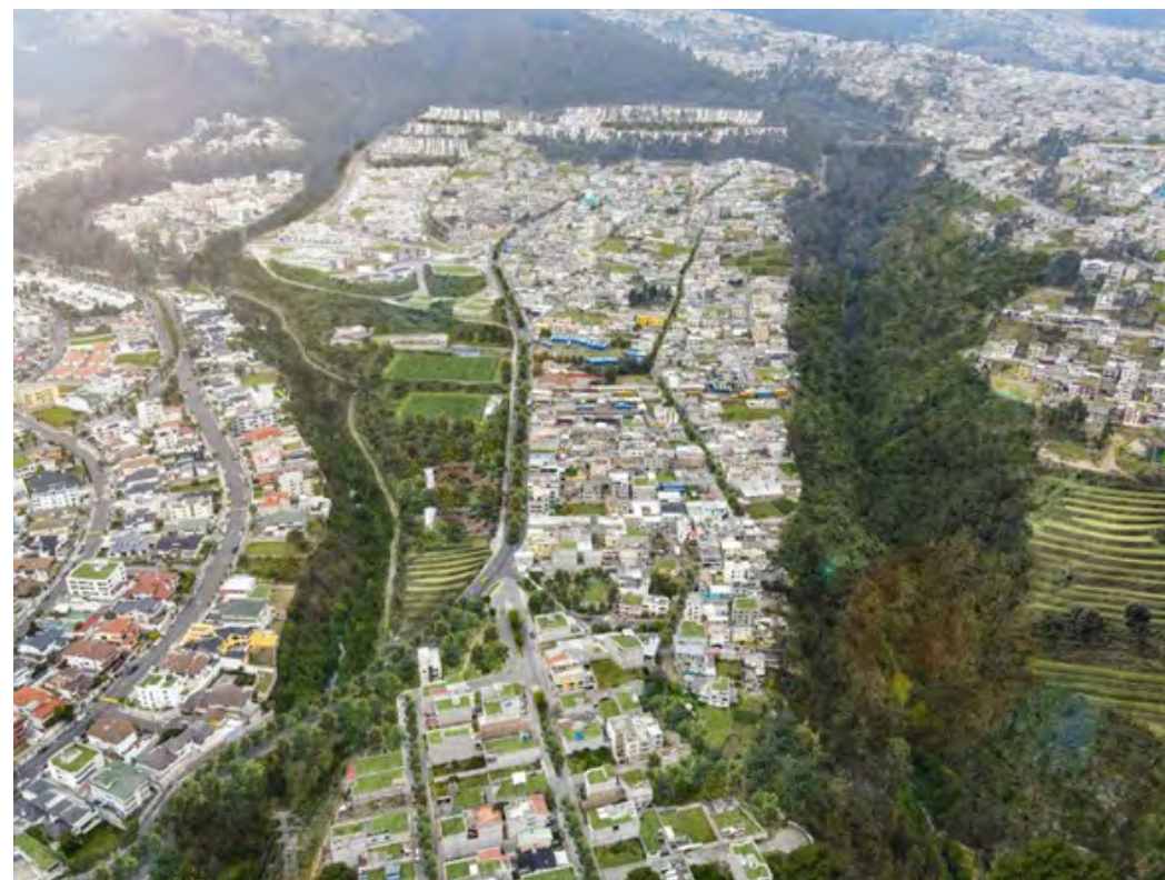
Figura 59. Fotografía aérea actual versus propuesta de un SEV que integre una infraestructura verde ambiciosa (YES Innovation, 2020).
