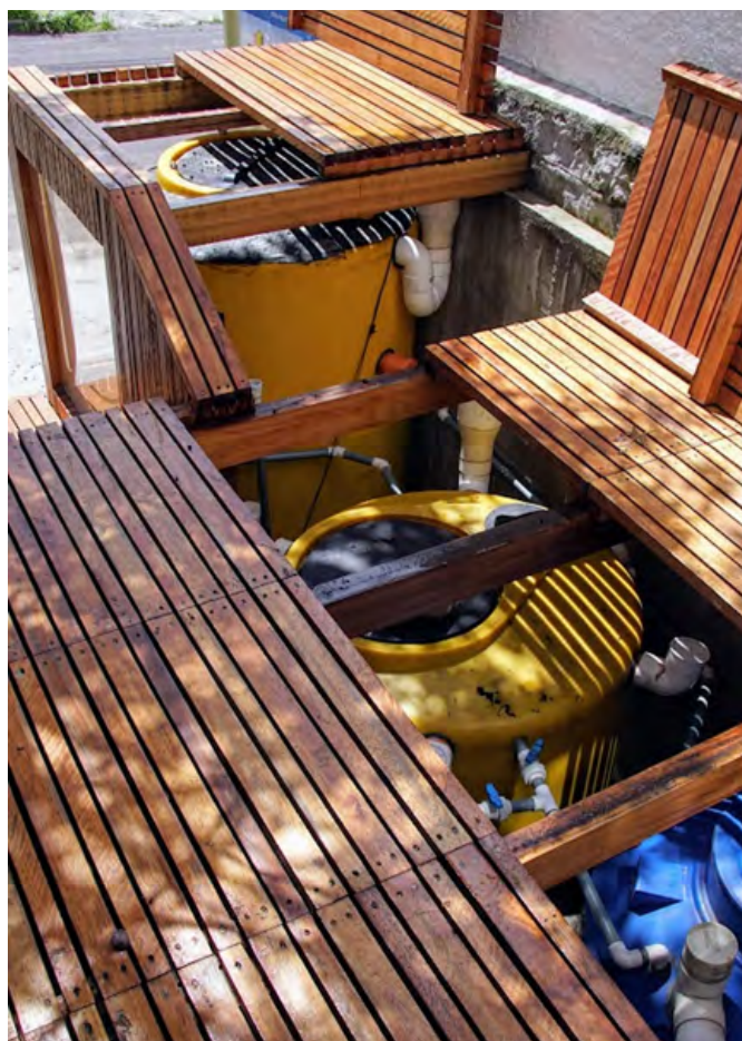
Figura 18. Sistema de tratamiento de aguas residuales autónomo y compacto Innoqua: representación esquemática, implementación en el Parque Caupicho e implementación en Casa Armero (YES Innovation, 2022).
