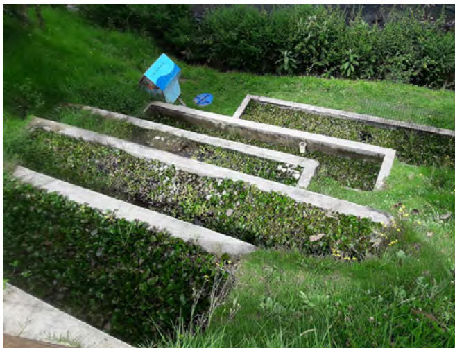
Figura 40. Sistema de fito-depuración implementado en el museo Yaku, Quito (Fotografía: YES Innovation, 2018).
